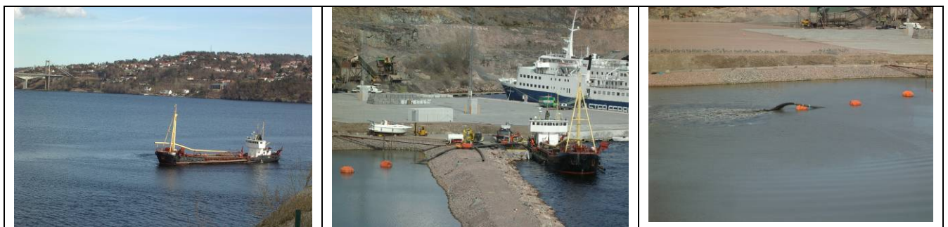
Figur 4.6.. Levering av masser til deponi foretas både med mudringsfartøy og lektere. Her levering av masser til deponi i mai 2006.
