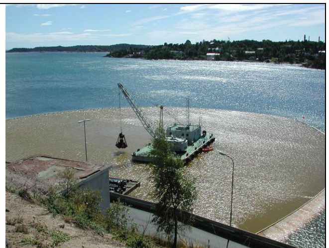
Siltskjørt etter utskiftning. Foto: Jon Egil Vinje, Multiconsult
