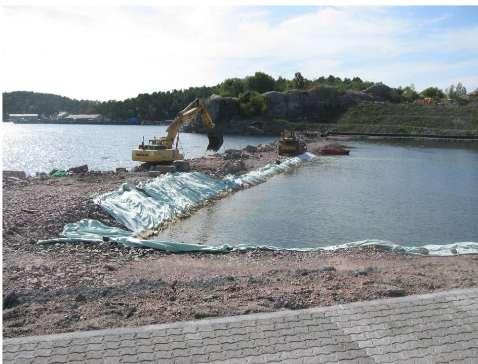
Figur4.2.. Foto som viser bygging av strandkantdeponi. Tildekking av fiberduk pågår.
