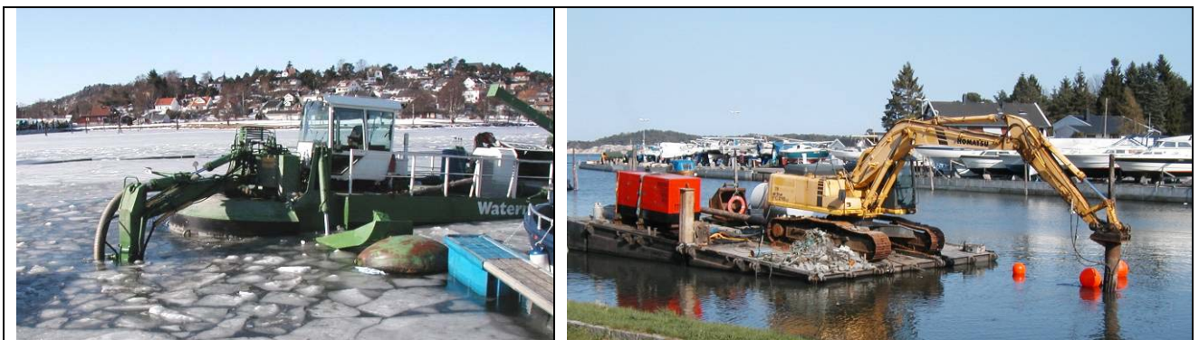
Figur 3.6. eksempel på bruk av mudringsutstyr i småbåthavnene
