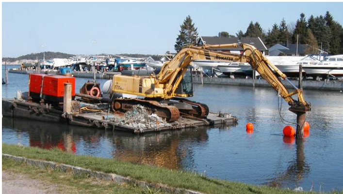
Figur 6.30. Komatsu mudringsenhet i arbeid i Auglandsbukta
