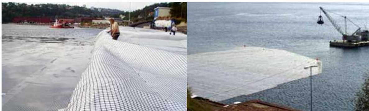
Figur 3.1. Bilder fra utlegging av armert fiberduk
