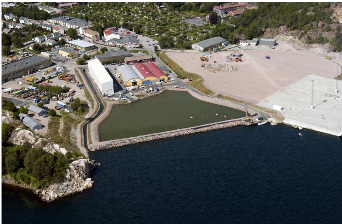
Figur 5 Strandkantdeponiet i Kongsgårdbukta, den omlagte Prestebekken er til venstre for deponiet, Foto: Tor Kviljo, Terrateknikk.
